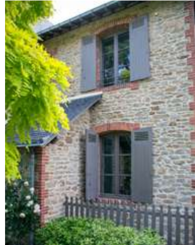
Finition des volets réalisée par le client
