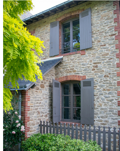
Finition des volets réalisée par le client
